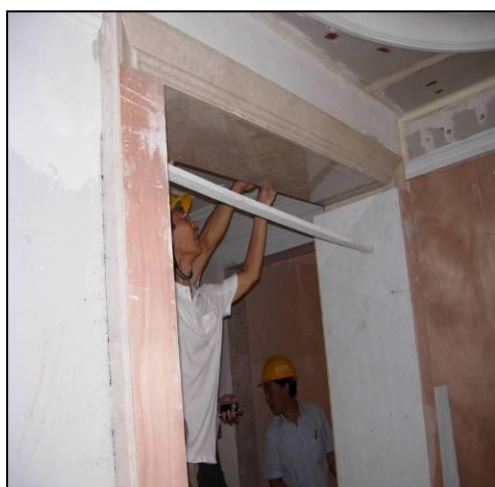
参考案例 17：对石材门套的保护处理
