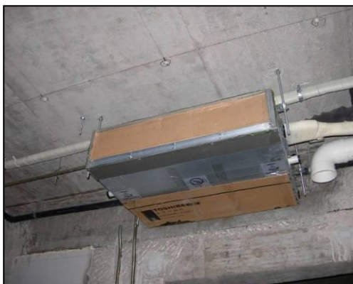
参考案例 6：将风管敞口用木夹板或硬纸板临时封闭，防止建筑垃圾和杂物进入风管
