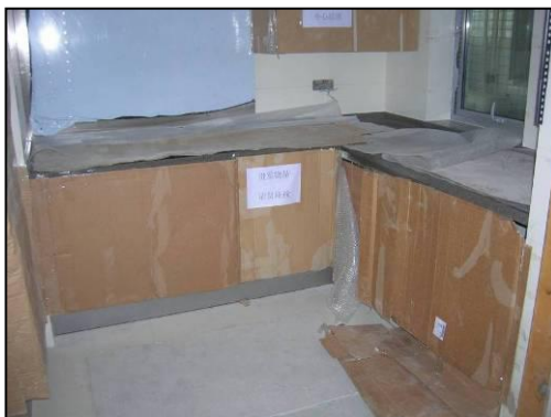
参考案例 40：使用软性材料对整体橱柜进行全面保护
