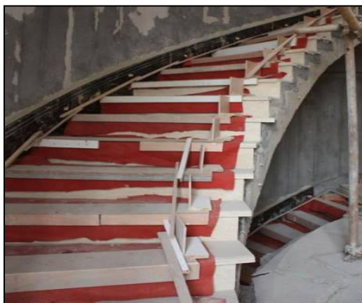
参考案例 46: 楼梯每个踏步先垫地毯避免划痕, 整条边钉接宽 12mm 多层板阳角条保护, 两侧杉木档连接成整体, 防止踩踏后滑落。
