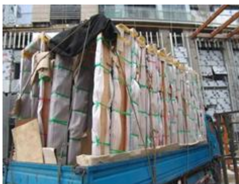
图 27 门框密闭包装，始终采用立式安放
