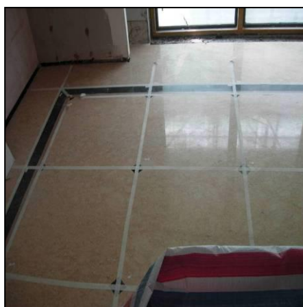
参考案例 22：地面美纹纸对嵌缝保护
