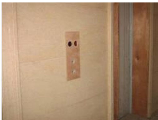
图 41 电梯厅墙面、门套及按钮保护
