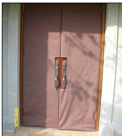
参考案例 32：门扇用布护套整个包覆，可防止碰撞、污染
