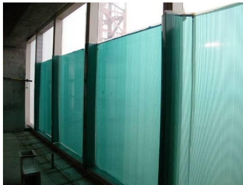
参考案例 4：在大面积室内施工开始后，要求对落地窗等低位玻璃采用板材隔离保护 (保护范围包括铝合金立档)
