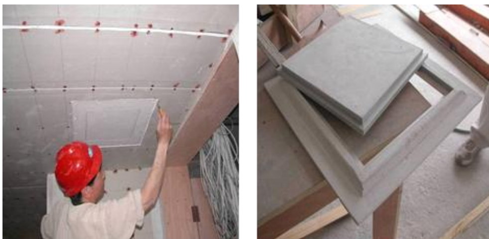
图 13 吊顶预留成品检修孔
