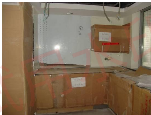
参考案例 41：使用软性材料对整体橱柜进行全面保护
