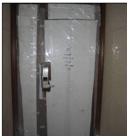
参考案例 33：进户门安装后包裹保护膜，五金件塑料膜保护
