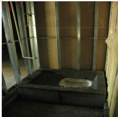
参考案例 2：临时用卫生间做法（高层项目必须强制推行，多层及其他物业形态可以参照执行）
