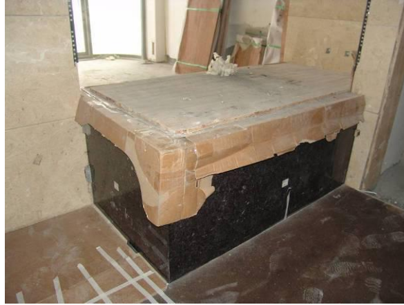
参考案例 18：石材台面的整体保护，应避免保护材料对石材面的划伤
