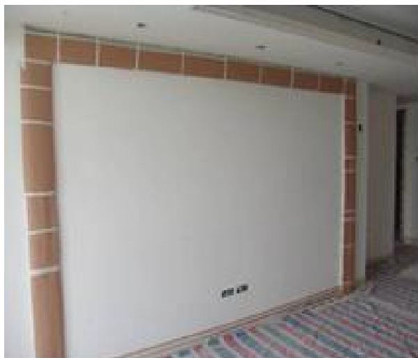
图 32 墙面造型线条保护
