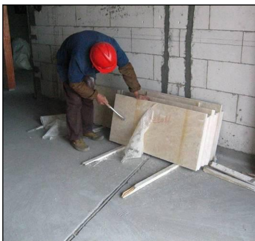
参考案例 12：石材的堆放应考虑便于二次搬运的需要，应确保有适当的倾斜度和防滑设置，堆积厚度应不大于 500mm
