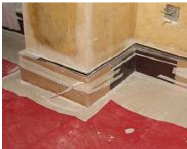
图 31 踢脚线阳角保护
