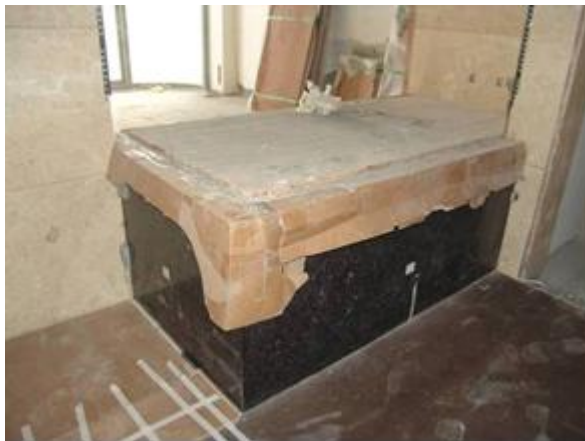
图 18 石材台面整体保护
