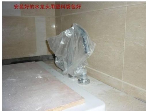
参考案例 44：龙头安装结束后的基本保护
