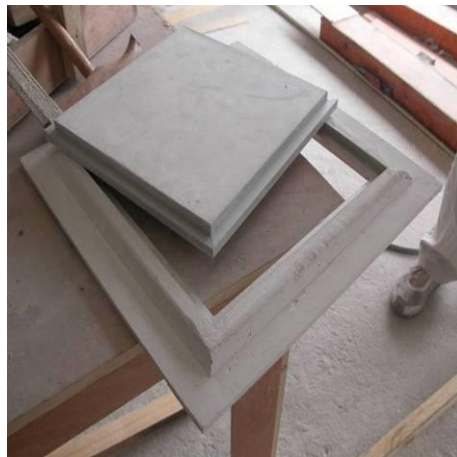
参考案例 13：吊顶预留成品检修孔
