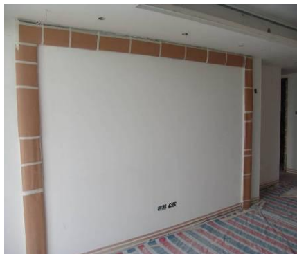
参考案例 35：墙面造型线条的成品保护
