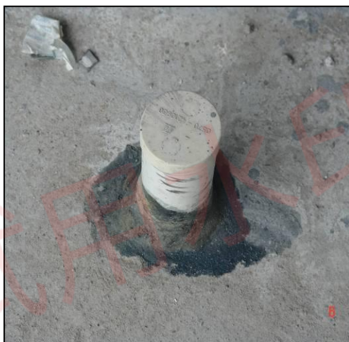
参考案例 7：采用塑料盖板对下水管道进行成品保护。
