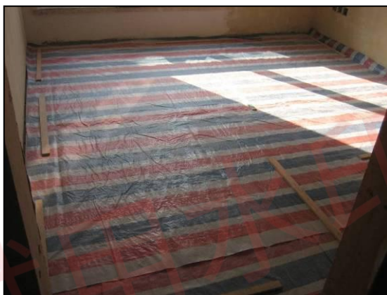
参考案例 25：木基层板铺装完成后成品保护
