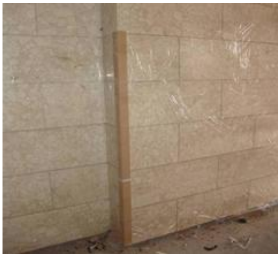
图 16 石材阳角及成品墙面保护图
