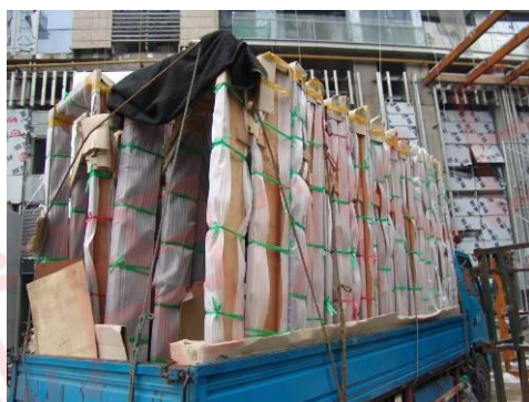
参考案例 29：门框密闭包装，始终采用立式安放
