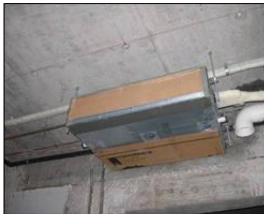
图 6 风机盘管保护
