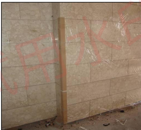
参考案例 16：对石材阳角及成品墙面的保护处理
