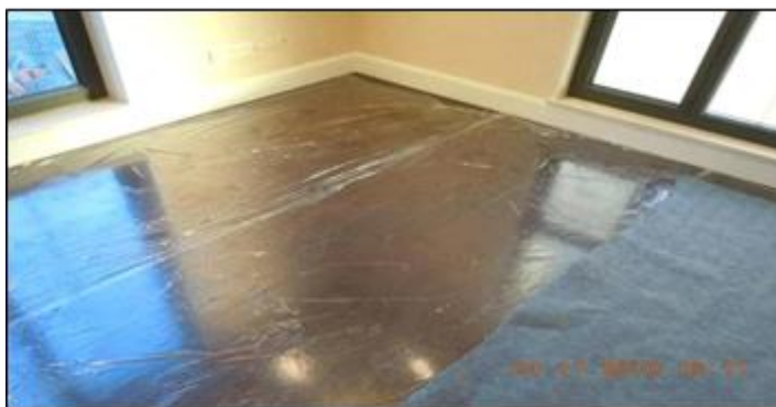
图 25 地板铺设保护膜
