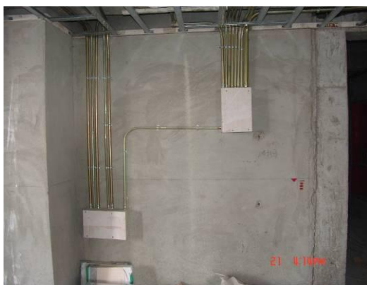
参考案例 8：对穿线完成后的强弱电箱采用多层板封闭保护
