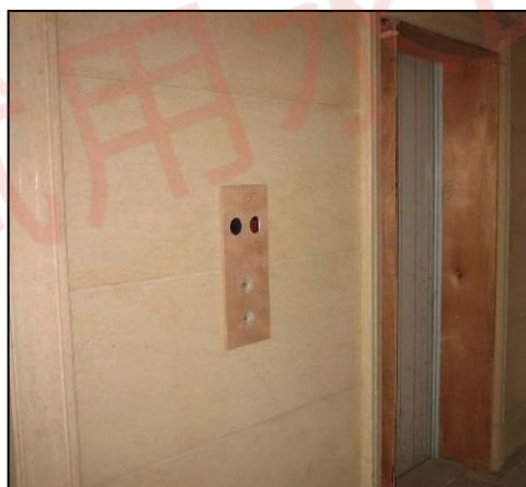
参考案例 47: 对电梯厅公共部位墙面石材门套及按钮有效保护
