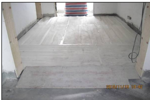
参考案例 15：地面石材铺贴完成清理干净并铺设地毯后采用双层中空瓦楞板保护，该保护材料具有缓冲压力的作用
