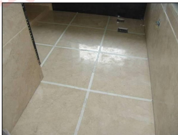
参考案例 14：对石材地面拼缝的保护处理
