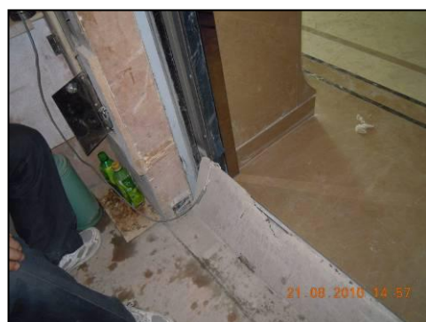
参考案例 48: 在施工后期使用电梯时, 除对轿厢进行保护外, 轿厢门槛处设置一块翻板, 防止杂物掉进电梯门槛槽内
