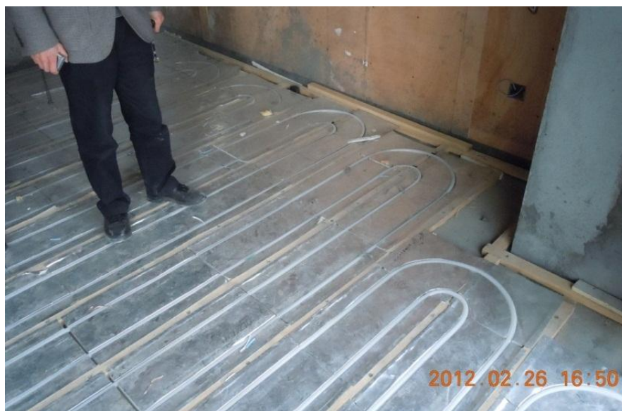
地热地板铺贴工艺示意
