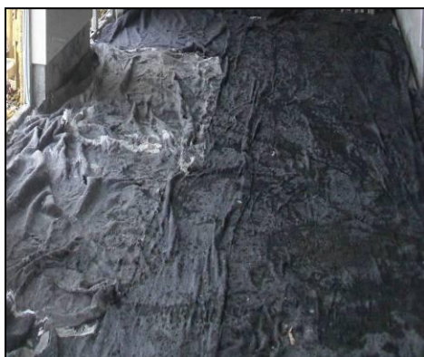
参考案例 20：地面砖施工完成表面洒水后覆盖毛毯
