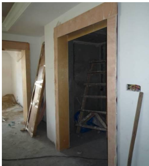
参考案例 31：门套安装完成后必须进行有效的成品保护（确保保护材料与木饰面软接触）
