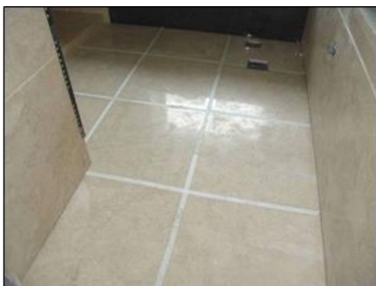
图 14 石材地面拼缝保护
