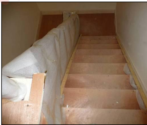
参考案例 45: 对已完成的楼梯基层板有效保护
