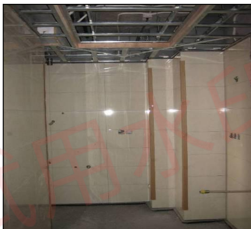
参考案例 24：塑料阳角条进行瓷砖阳角保护
