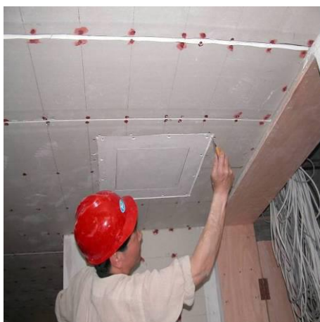
参考案例 13：吊顶预留成品检修孔
