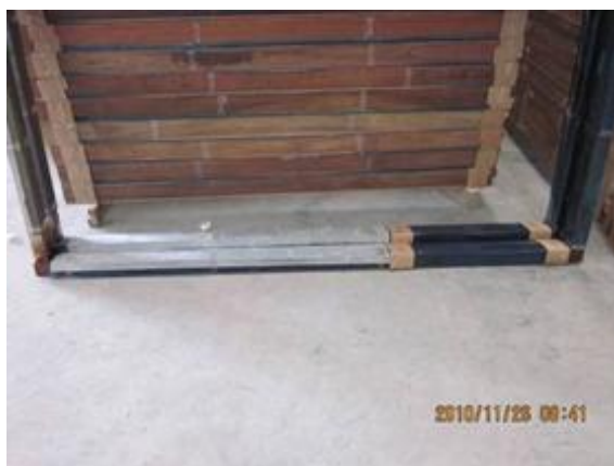
图 10 不锈钢门槛用白铁皮保护
