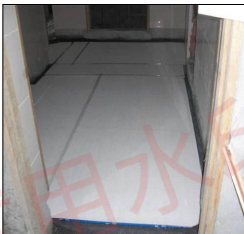
参考案例 21：覆盖毛毯后再铺一层跪钙板，板缝间粘贴胶带纸
