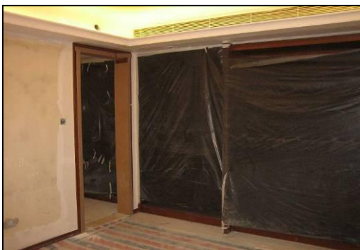
参考案例 30：门套安装完成后必须进行有效的成品保护（确保保护材料与木饰面软接触）
