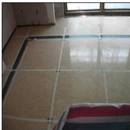
图 21 瓷砖地面美纹纸对嵌缝保护
