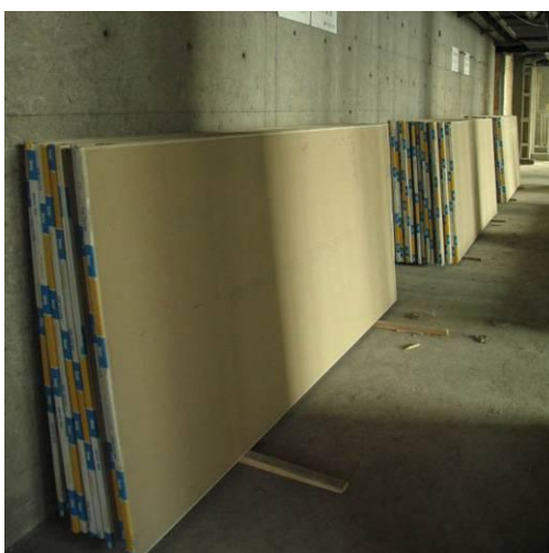
参考案例 11：石膏板侧靠堆放时，底部应垫木方并有抗滑移设置。此种堆放方式时间不宜超过五天，并且要确保堆放在非主要出入口和施工操作面。堆放时倾斜度应超过 80 度。堆放厚度不宜超过 300mm
