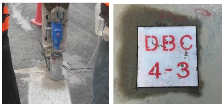
图 5.5-1 周边地表沉降监测点埋设示意图
