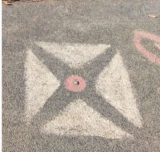
图 5.4-1 路基、边坡沉降监测点布设示意图
