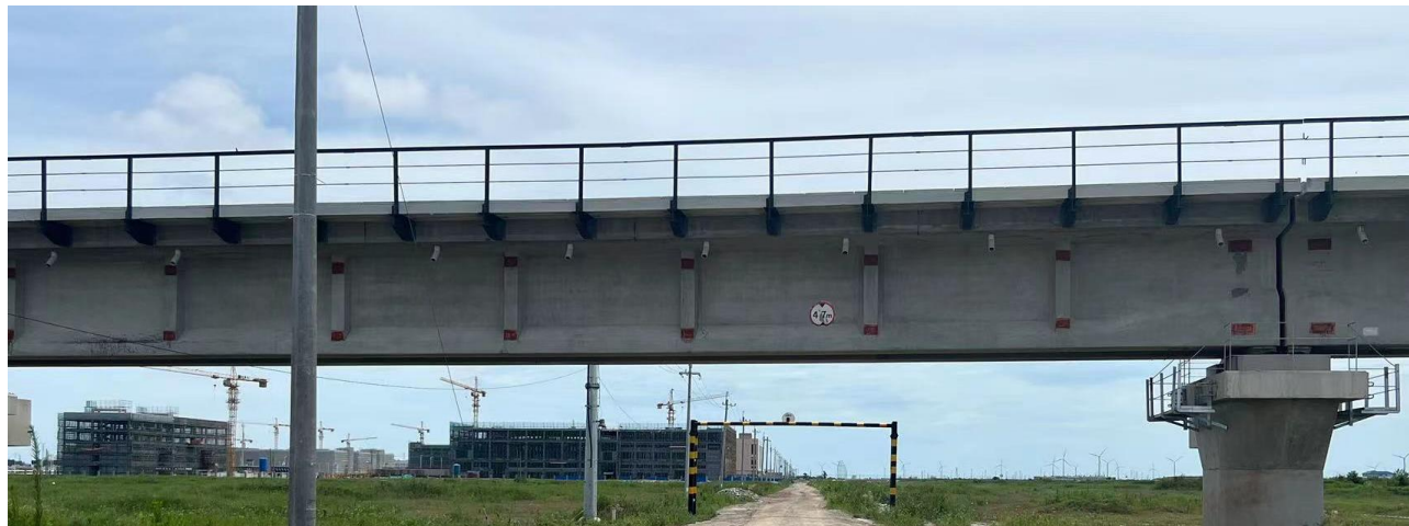
图 6.1 铁路桥现状排水方式
