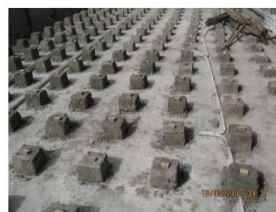
混凝土柱子架空龙骨
