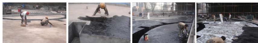
基层清扫 → 冷底子油一道 → 聚氨酯防水涂层第一遍 → 铺设玻璃纤维网格布
