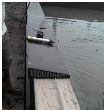
止水钢板，胶泥封口
