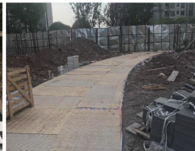
方案二：薄膜加彩条布加竹夹板（大芯板）
