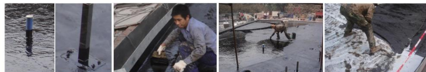
细节处理 ← 细节处理 ← 聚氨酯防水涂层第三遍 ← 聚氨酯防水涂层第二遍
