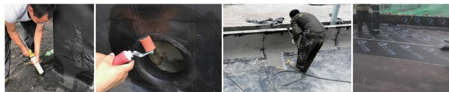
EPDM防水层打胶 → EPDM防水层管口处理 → 卷材搭接 → 卷材防水
