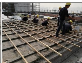
混凝土墙架空龙骨
