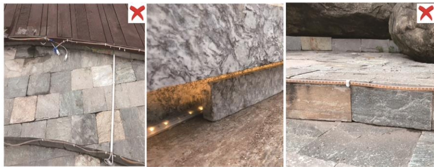
灯带安装线管外露，杂乱
