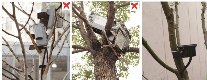
选型错误，照射方向应该射向树冠，固定方式错误。
